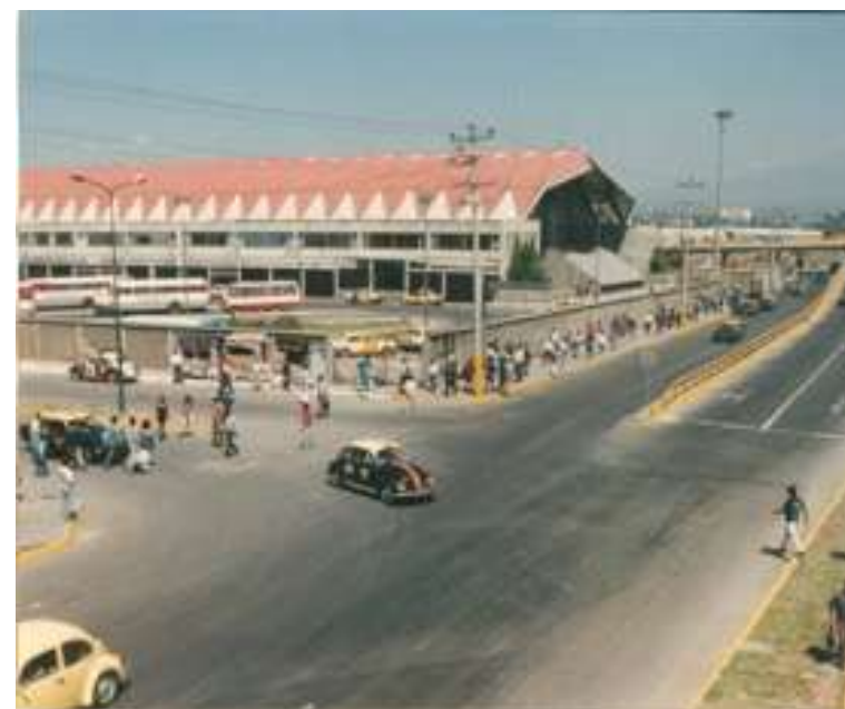
Vista lateral de la Central de Autobuses de Puebla (CAPU), se aprecia el distribuidor vial Carmen Serdán. AGMP. Material fotográfico, RCB-727, 1993-1996.
